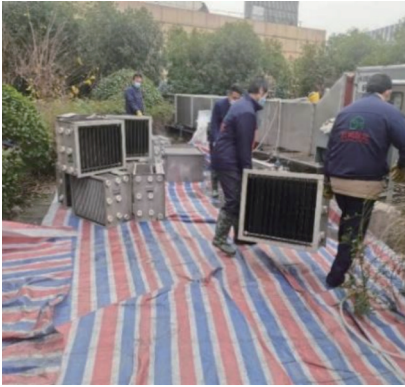
油煙管道、淨化器清潔過程
