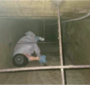
油煙管道、淨化器清潔過程
