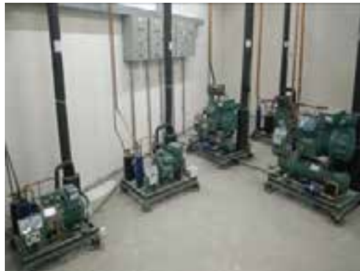
超市冷鏈製冷機組（左圖）與冷鏈冷凝器（右圖）
