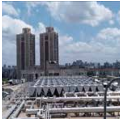
空調機組隔音屏安裝前（左圖）後（右圖）對比
